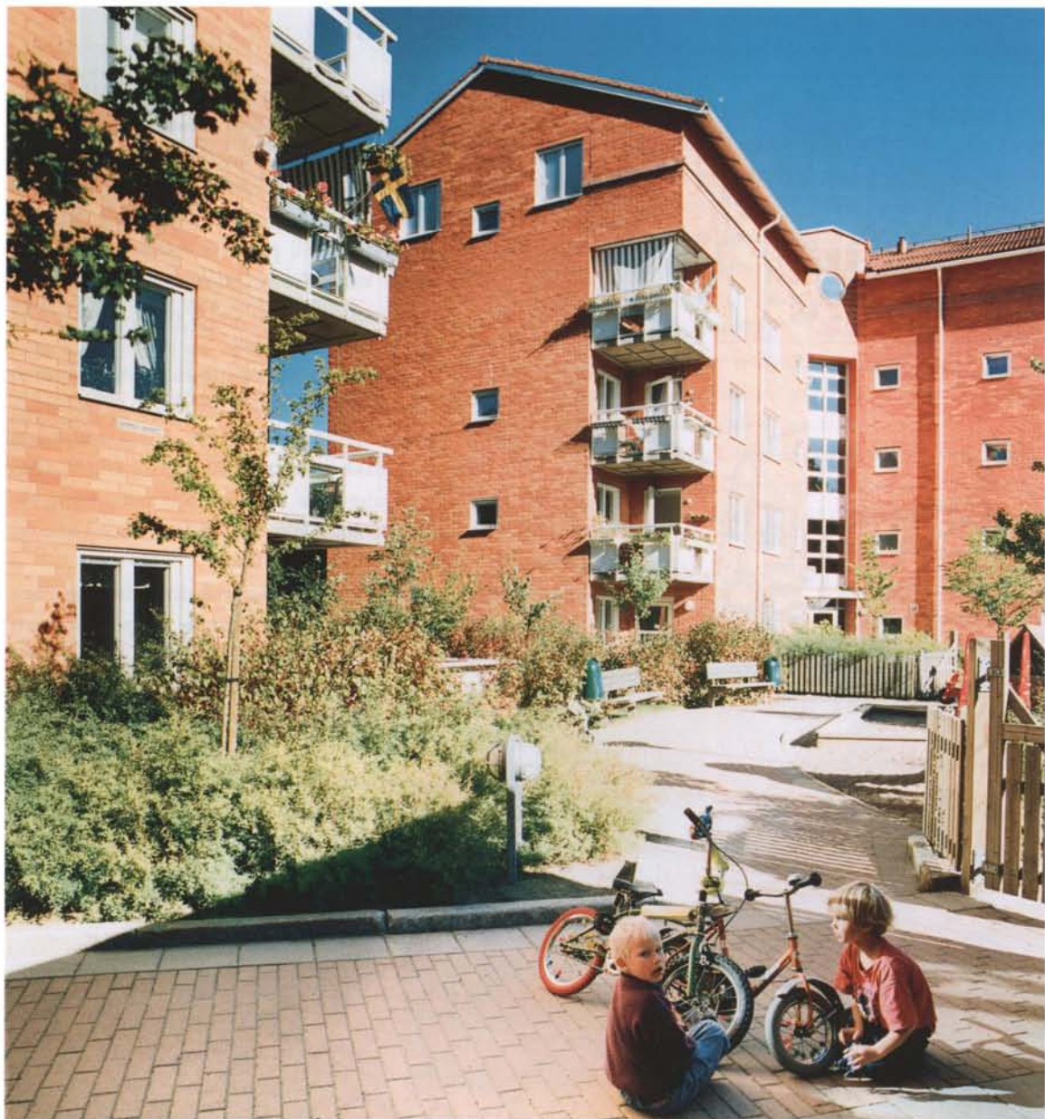
I Bagarmossen kompletterade Stockholmshem sina 50- och 60-talskvarter med ny bebyggelse nära centrum i slutet av 80-talet.
