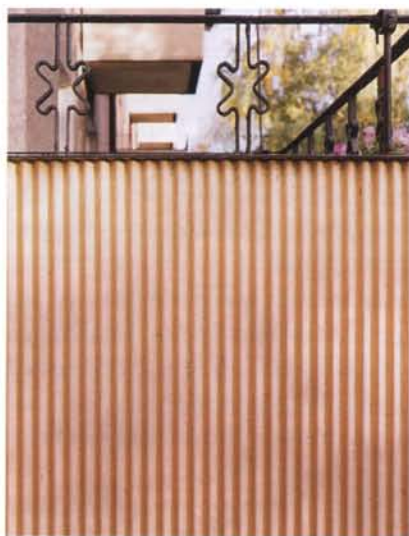
Balkongfronter i originalutförande med sinus-korrugerad plåt och tidstypisk smidesdekor.
