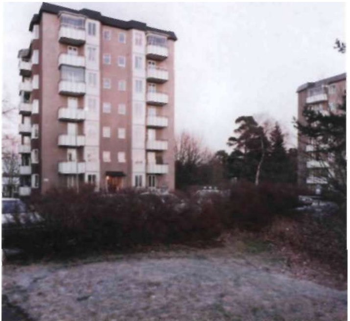
Några av hyresgästerna i höghusen vid Rubinvägen har låtit glasa in sina balkonger.
