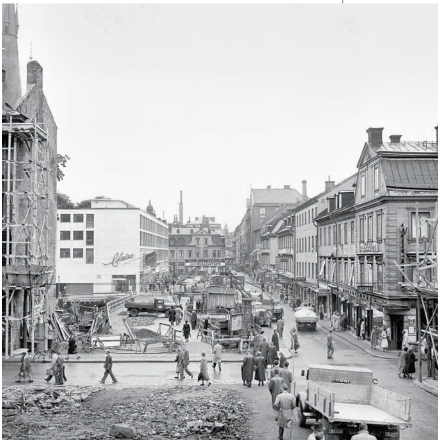
«Husrivningar i hörnet Klarabergsgatan/Drottninggatan.» Det nybyggda vita huset till vänster vid Klarabergsgatan blev evakueringshus åt olika företag som förlorat sina lokaler. Det uppfördes ovanpå tunnelbanan. I stället för det rivna «Husmoderns varuhus» öppnade modehuset «Claire», medan konditori «Kafferepet» behöll sitt gamla namn när man flyttade över gatan. Längs den högra sidan vid den avsevärt breddade gatan ligger idag «Åhléns». Foto: Åke Blomqvist, SvD, 15 september 1955, SSM.
