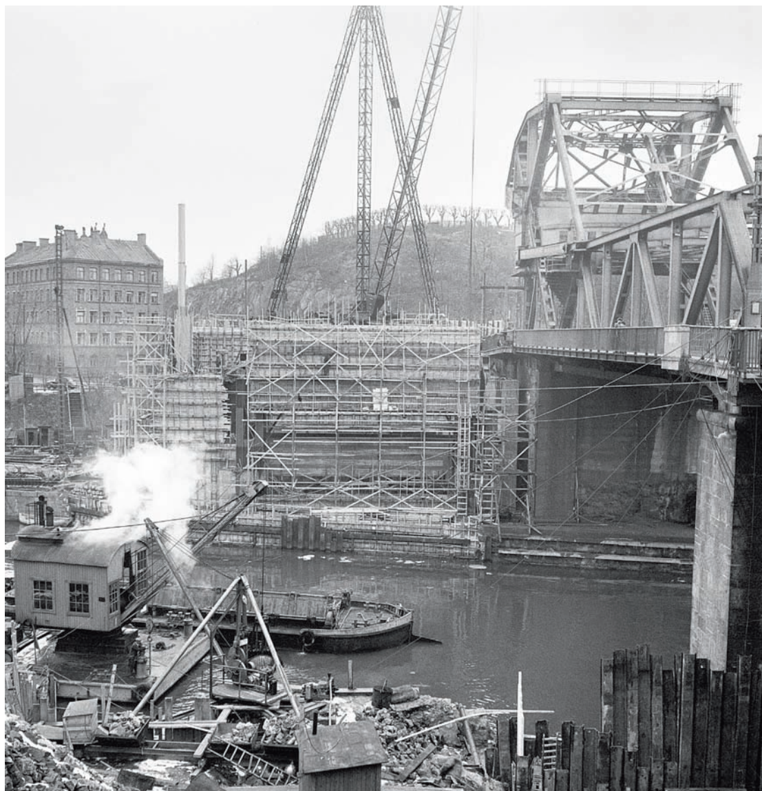
«Brobygget pågår vid Danvikstull.» Danviksbron som byggdes 1918–1922 dubblerades med en ny bro bara en meter bredvid den gamla. Till vänster, vid Danviksgatan låg Liljeholmens stearinfabrik. Foto: Gunnar Lantz, SvD, 6 april 1955, SSM.
