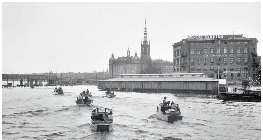
«Småbåtars hemkomst från söndagsturen.» I bakgrunden har arbetet med Centralbron och tunnelbanebron över Riddarfjärden börjat. Till höger den flytande fiskhallen vid Kornhamnstorg. Foto: Åke Blomqvist, SvD, 31 juli 1955, SSM.
