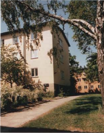
Gavlarna tilläggsisolerades vid ombyggnaden och fönstren flyttades ut i det nya fasadlivet.
