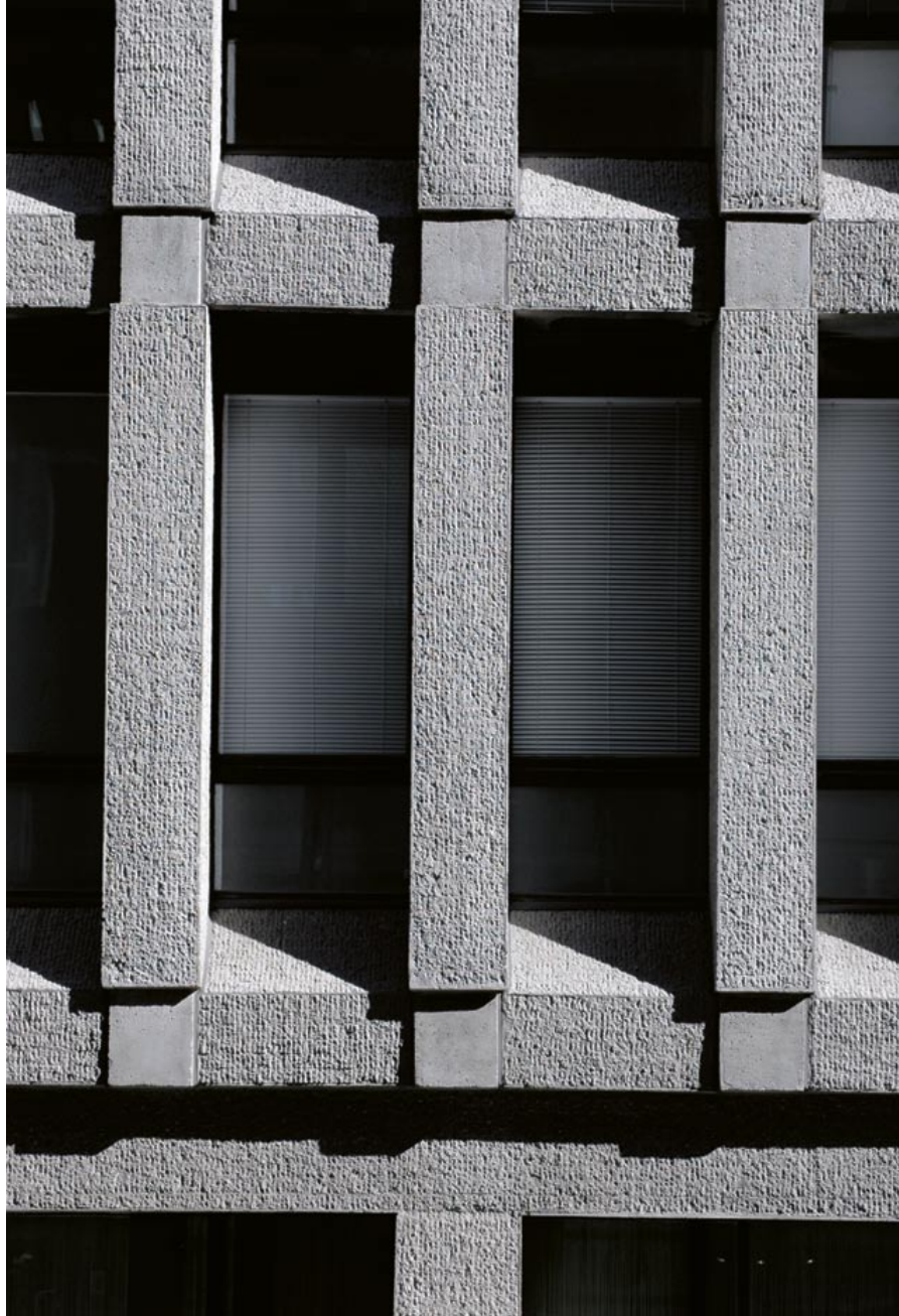
Betong användes som fasadmateriäl. Ibland obehandlad, men ofta mycket medvetet utformad. I Sverige- huset göts betongelementen mot en rutindelad form som sedan höggs med mejsel eller hammare så att skarpa brottytor framträdde. Arkitekten Sven Markelius experimenterade med gamla äggkartonger, gum- mimattor m.m., innan han hittade en gjutform som passade. Foto: Göran Fredriksson, SSM.
