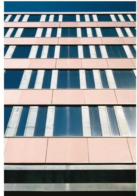
Det blåtonade glaset skapade ett bättre inomhusklimat. Arkitekten Sune Malmqvist lade stor omsorg vid anpassningen av husets färg och form till omgivningen. Trollhättan 31. Foto: Göran Fredriksson, SSM.
