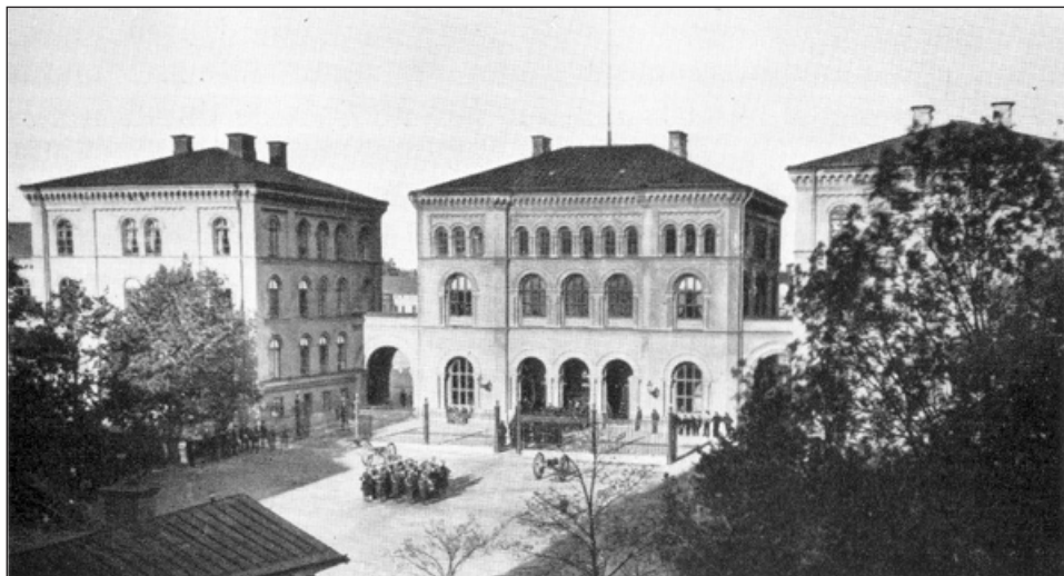
Svea Artilleriregementets (A1) kaserner 1877 innan Valhallavägen utlagts. I hörnet till vänster skimtar taket till en av de två tullstugorna. Båda stugorna revs när Valhallavägens norra körbana skulle anläggas. (Källa: Christian Laine, Kasernen vid Valhallavägen. ) SSM.
