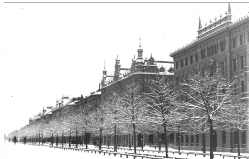
Valhallavägen i vinterskrud med sina nyplanterade alléträd. Närmast till höger nr 92 och 94–96 från 1885 och 1887. Foto omkr 1900. SSM.
