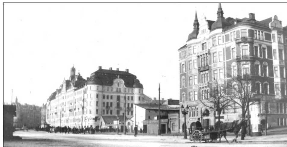
Byggnaden på Strandvägen med nummer 1–5 var länge Stockholms största privathus. Det stod klart att ta emot de första hyresgästerna 1904. Hörnhuset nr 9 i hörnet av Strandvägen och Skeppargatan var inflyttningsklart redan 1900. SSM.
