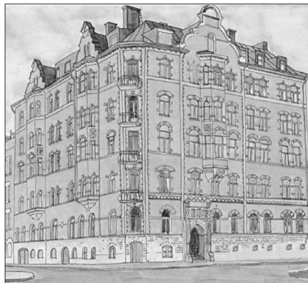
Valhallavägen 130 (fd 13) i hörnet av Jungfrugatan, stod klart 1896 och var länge det östligaste huset på Valhallavägen. Byggnationen på andra sidan av Jungfrugatan fortsatte först 1923–24.
