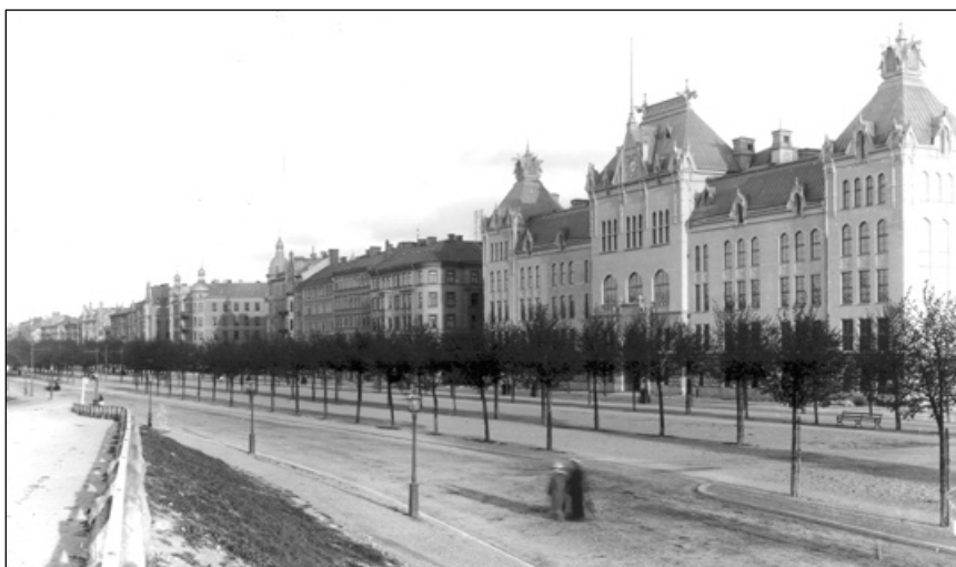
Engelbrektsskolan Valhallavägen 76 mitt emot Östra station invigdes 1902. Längre bort skymtar hörnhusen nr 84 och 86 vid Lill-Jans plan. De byggdes under åren 1895–1897. SSM.
