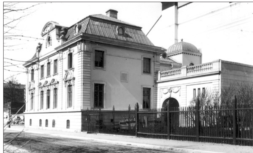
Falkmanska villan, även kallad Liljewalchs villa byggdes 1901-1902. Den fick dock inte stå kvar längre än till 1964. SSM.
