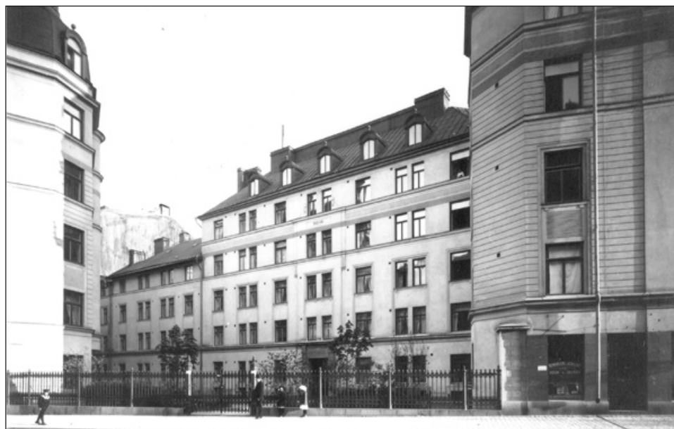
Hemgården, Östermalmsgatan 68 (fd 27). Bilden visar den "inkapslade gatstumpen" från gamla Ladugårdslands Tullgata, nu Östermalmsgatan. Foto 1912 A. Malmsten, SSM.
