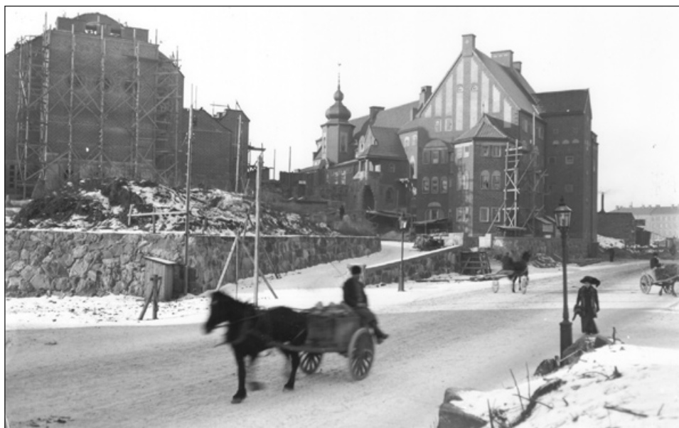
Engelbrektskyrkan under uppförande. Rakt fram Engelbrekts församlingshus som invigdes 1911. Foto omkr. 1912. SSM.
