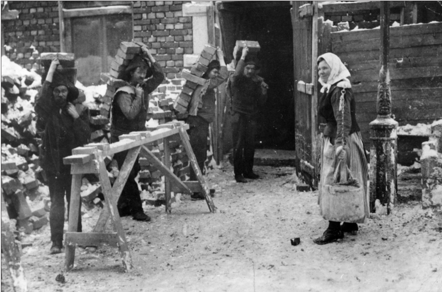
Ännu en bit in på 1900-talet anlätades kvinnor i byggnadsarbetena. På rangliga och bristfälliga byggnadsställningar bar kvinnorna tunga murbrukshinkar för en mycket låg timpenning. Inte underligt att de så kallade mursmäckorna 1888 gick i strejk med krav på högre lön och bättre arbetsvillkor. Lägg märke till de två utskjutande stenarna vid axeln som fungerade som stöd. Foto ARAB.
