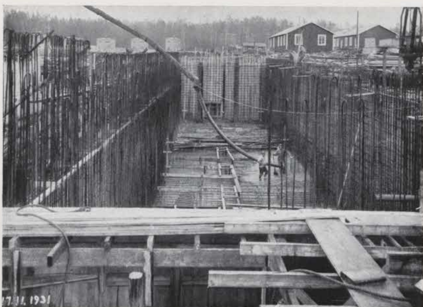
Armering av renvattenbehållare.
