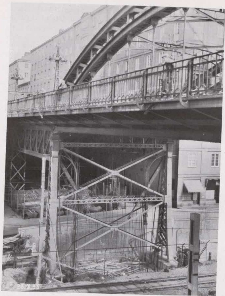
Fig. 6. En av gamla brons fackverksbockar före inbetoneringen.
