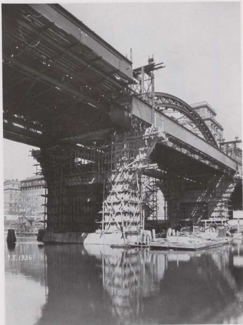
Fig. 15. Montage av stälöverbyggnaden. Andra byggnadsskedet.
