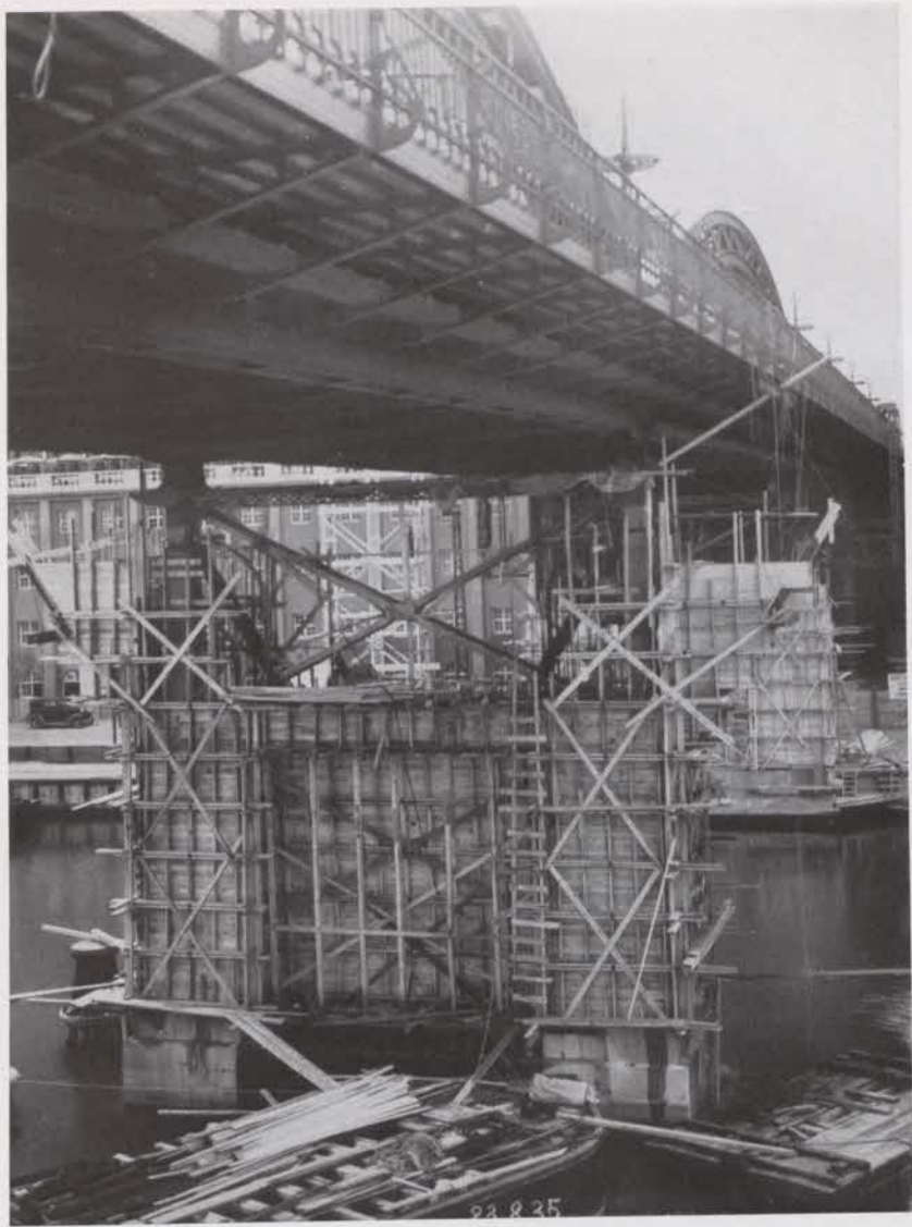
Fig. 10. Formsättning för en mellanpelare.
