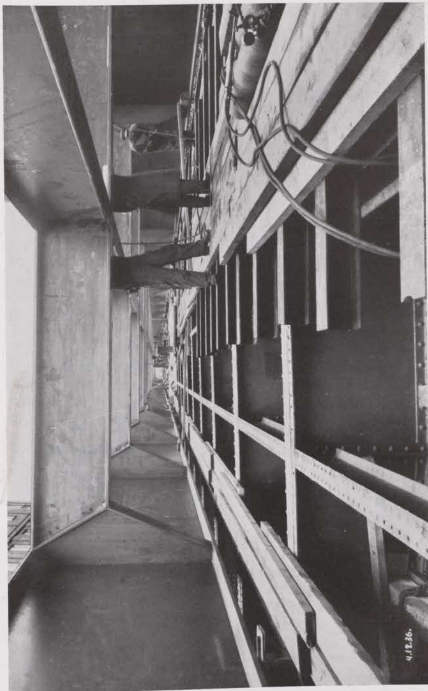
Fig. 18. Stälöverbyggnadens mellersta del, vilande på den gamla överbyggnadens tvärreglar. Tredje byggnadsskedet.
