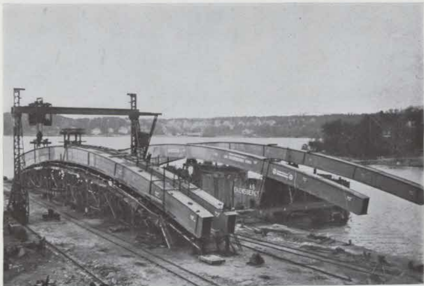
Fig. 14. Båghalvor upplagda vid Ekensbergs varv.
