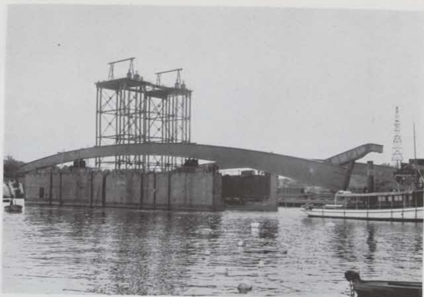
Fig. 19. 168 m-spannets snabelformiga förlängning.
