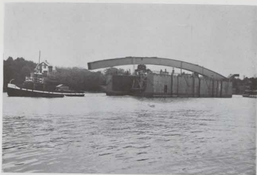
Fig. 15. Båghalva under bogsering till broplatsen.
