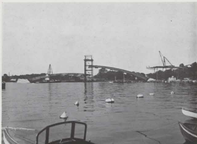
Fig. 20. Lyftning av bågarna.
