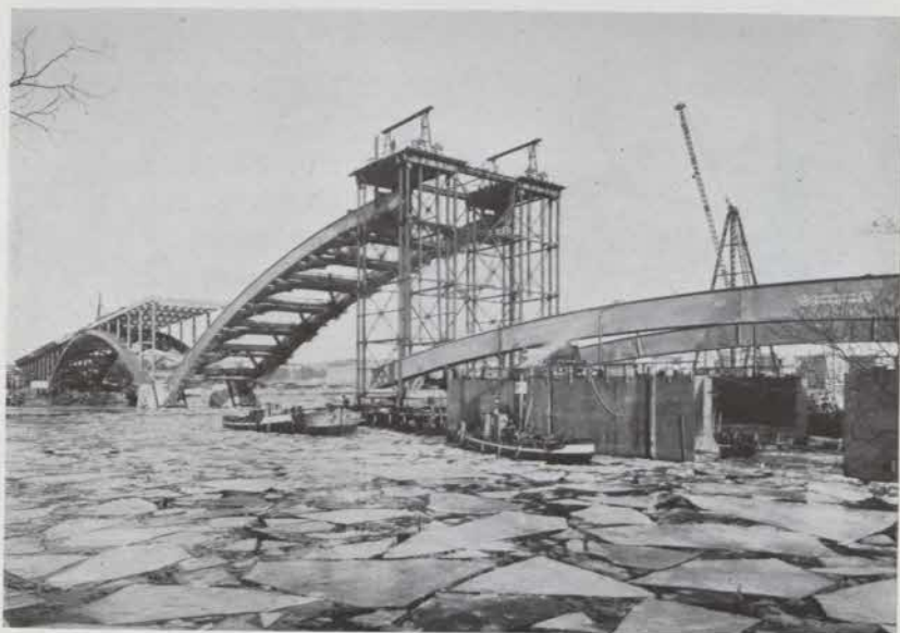
Fig. 21. 204 m-spannets norra bågar hängande i lyfttornet.
