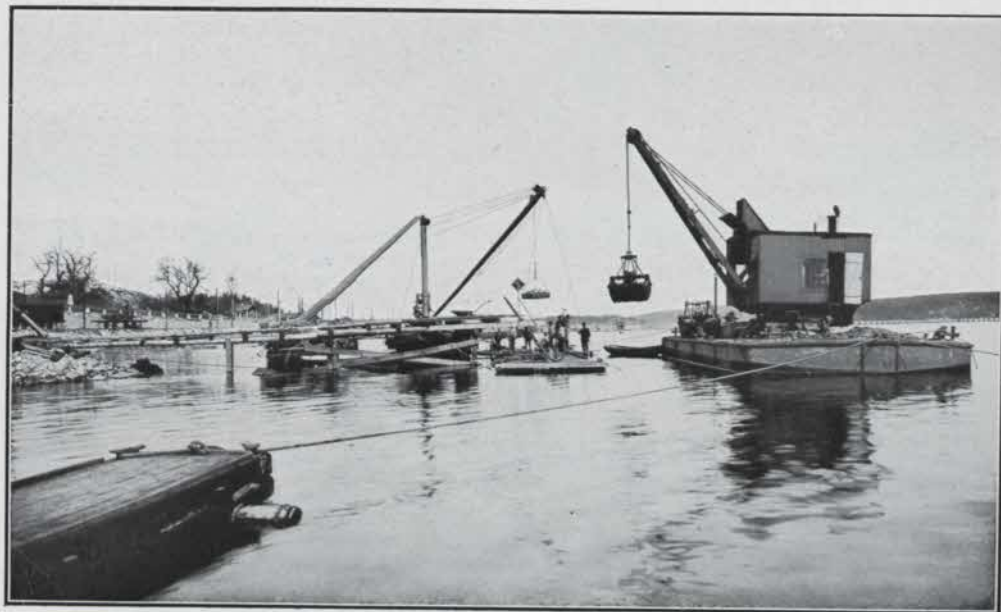
NYA HAMNBYGGNADEN. MUDDRING OCH SPRÄNGNING FÖR SÄNKKISTORNA.
