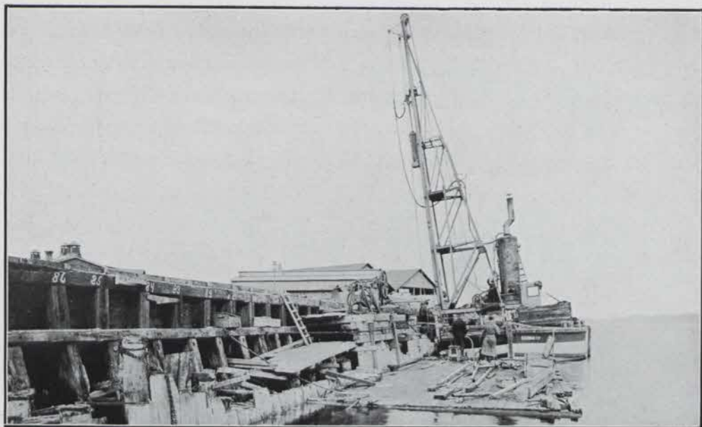
OMBYGGNAD AF SÖDRA KAJEN. NEDSLAGNING AF BJÄLKSPONT.
