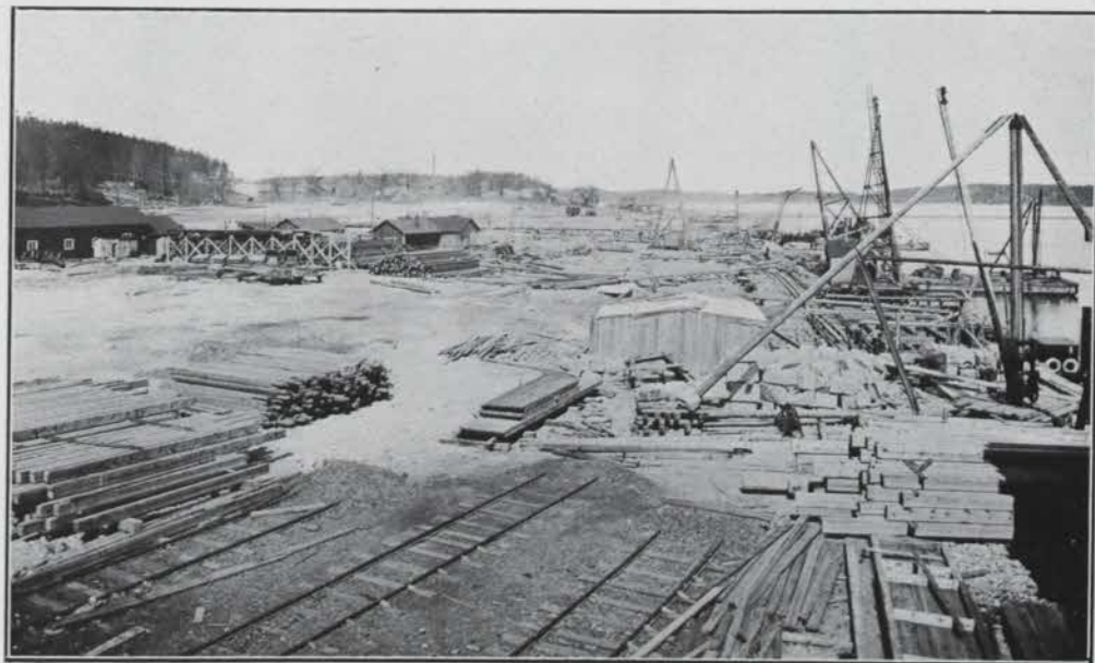
NYA HAMNBYGGNADEN. TOTALVY ÖFVER ARBETSPLATSEN ÅR 1910.
