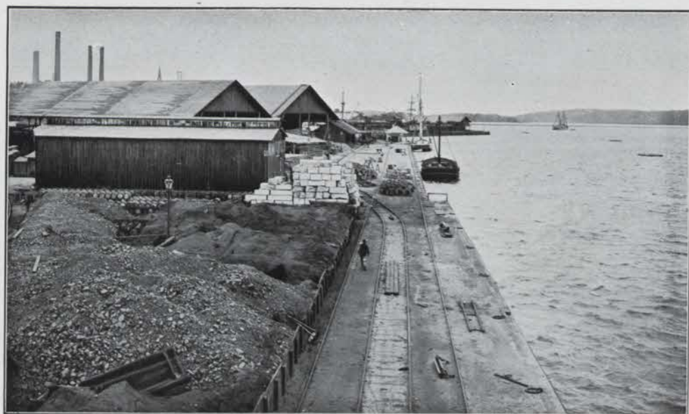
SÖDRA KAJEN I GAMLA HAMNEN, DELVIS OMBYGGD.
