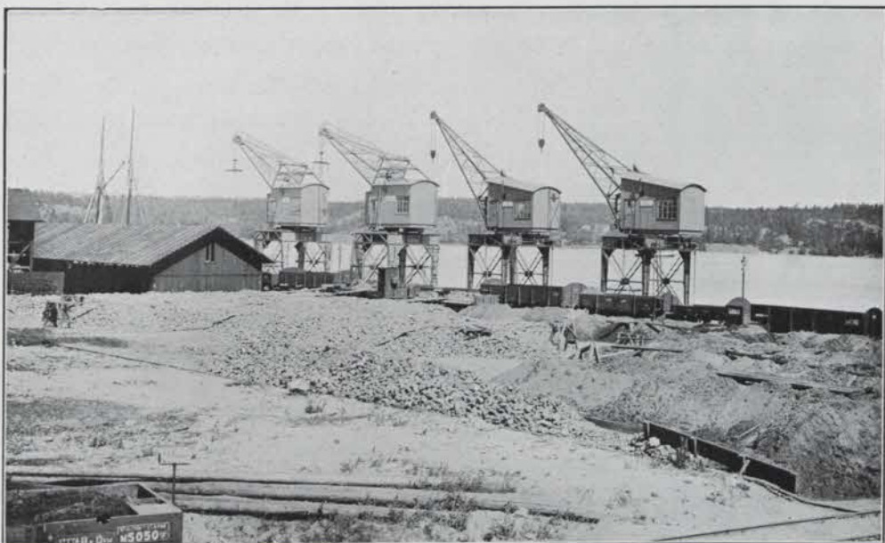
MALMLASTNINGSKAJEN I HARNENS SÖDRA DEL.
