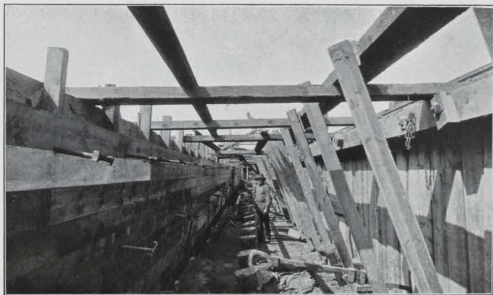
OMBYGGNAD AF NORRA BASSÄNGKAJEN. KAJMURNING INOM LÄNSPUMPAD FÅNGDAMM.
