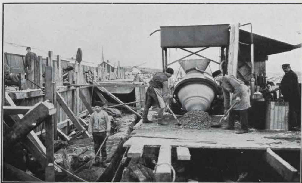
OMBYGGNAD AF NORRA BASSÄNGKAJEN. BETONGJUTNING FRÅN BLANDNINGSMASKIN UPPSTÄLLD PÅ PRÄM.
