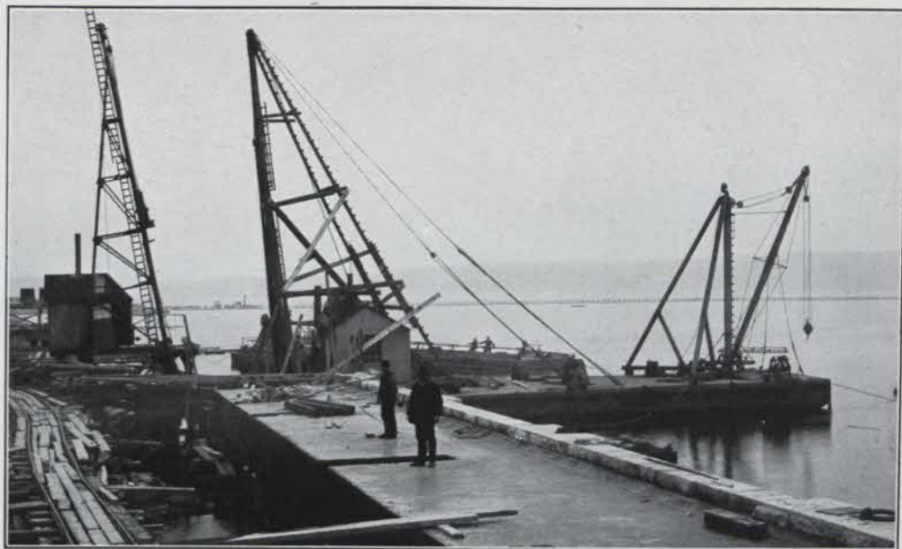
NYA HAMNBYGGNADEN. BROKAJ AF ARMERAD BETON PÅ KISTPELARE, SEDD FRÅN LAND.
