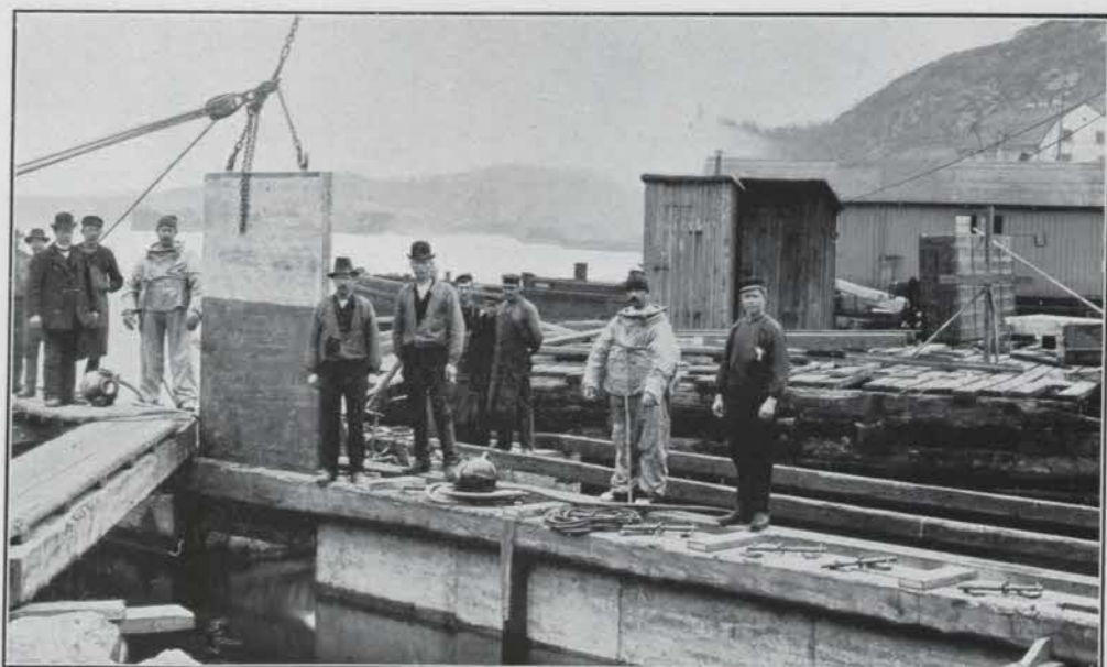
ANBRINGANDET AF BAKSPONT AF ARMERADE BETONPLATTOR VID VÄSTRA KISTPELARKAJEN I TEGELVIKSBASSÄNGEN.
