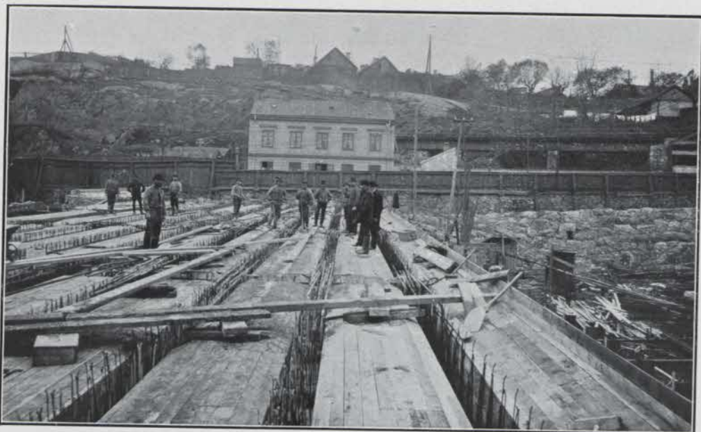
UPPFARTSVIADUKTEN FRÅN STADSGÅRDSHAMNEN TILL FOLKUNGAGATAN UNDER UPPFÖRANDE (LONDONVIADUKTEN).
