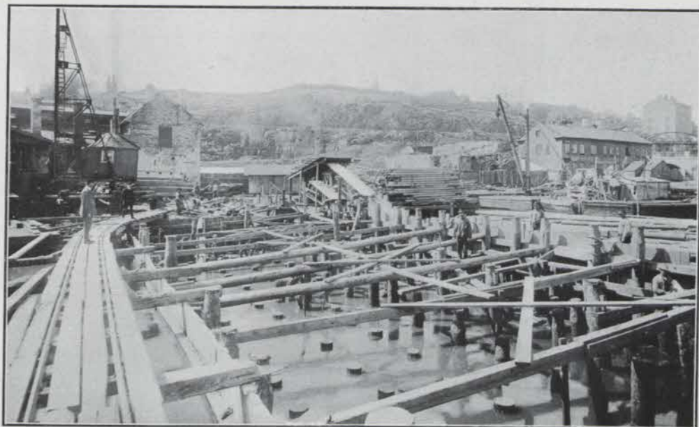
INDÄMNING FÖR PÅLPLATTFORM UNDER ÖSTRA KAJEN I TEGELVIKSBASSÄNGEN.
