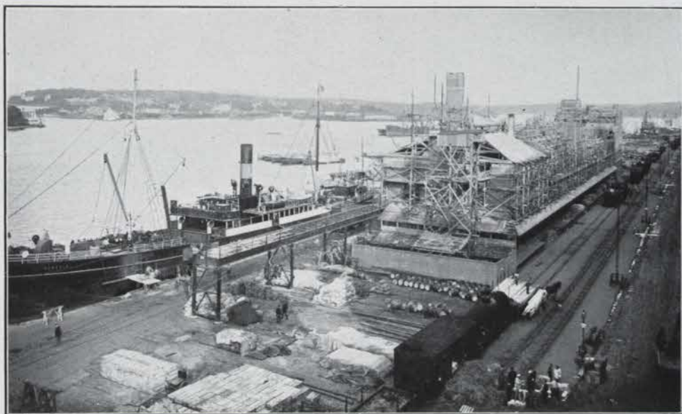
NYA HAMNEN MED STORA TULLBYGGNADEN UNDER PÅBYGGNAD FRÅN SÖDERBERGS TRAPPOR.
