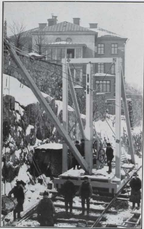
SPRÄNGNING AF ÖFRE BERGPALLEN NEDANFÖR ERSTA.
