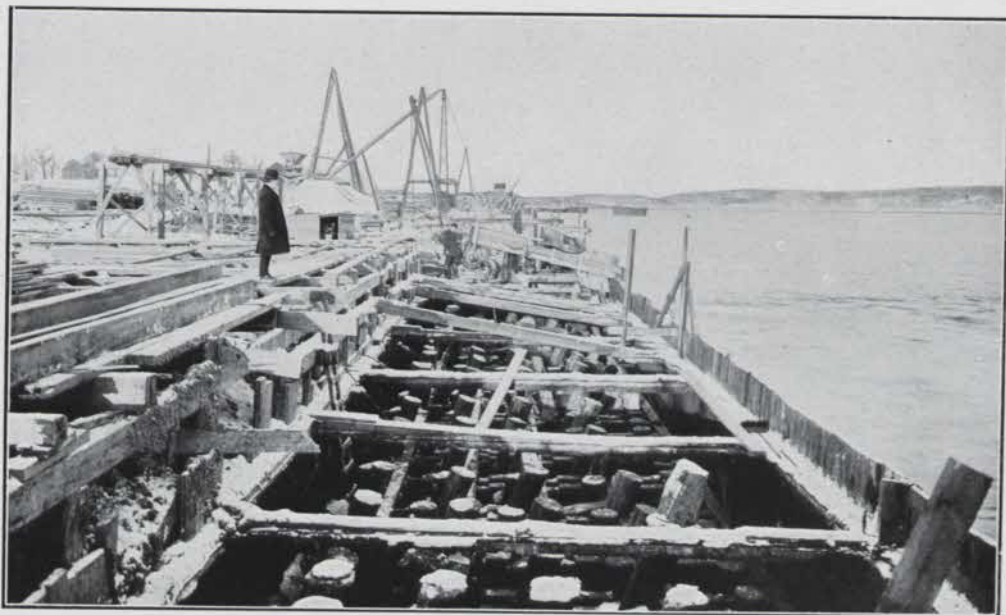
NYA HAMNBYGGNADEN. KAJPÅLARNAS FÖRBINDANDE MED BJÄLKRUST INOM FÅNGDAMM.
