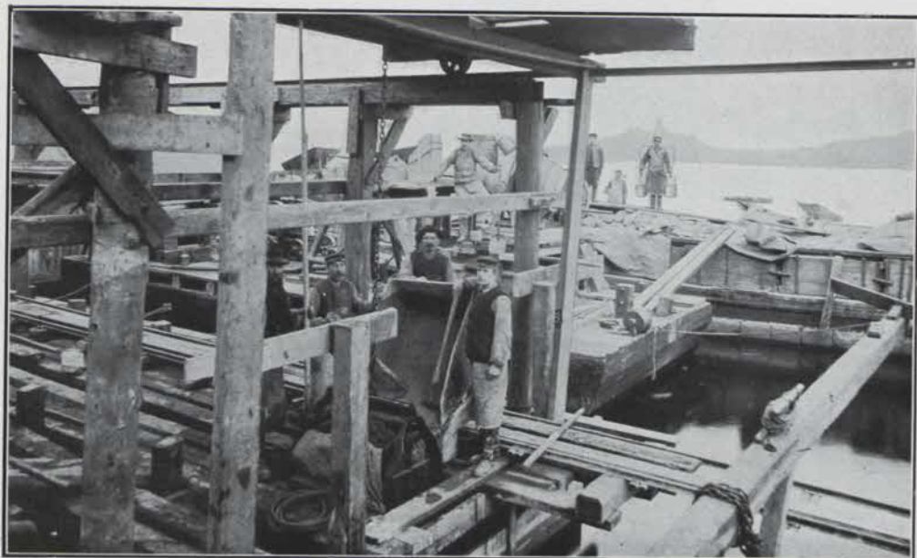
BETONGJUTNING I TIMMERKISTORNA MEDELST SÄNKLÅDOR MED BOTTENLUCKOR.
