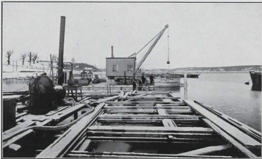
NYA HAMNBYGGNADEN. SÄNKKISTOR MED PÅSATT KASSUNER FÖRE LÄNSPUMPNINGEN.
