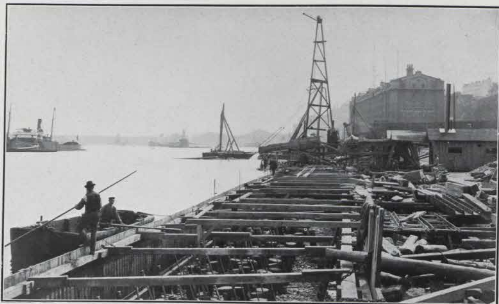
STADSGÅRDSHAMNENS INRE DEL. LÄNSPUMPAD INDÄMNING VID KAJBYGGNADEN FÖRE BETONGJUTNINGENS PÅBÖRJANDE.
