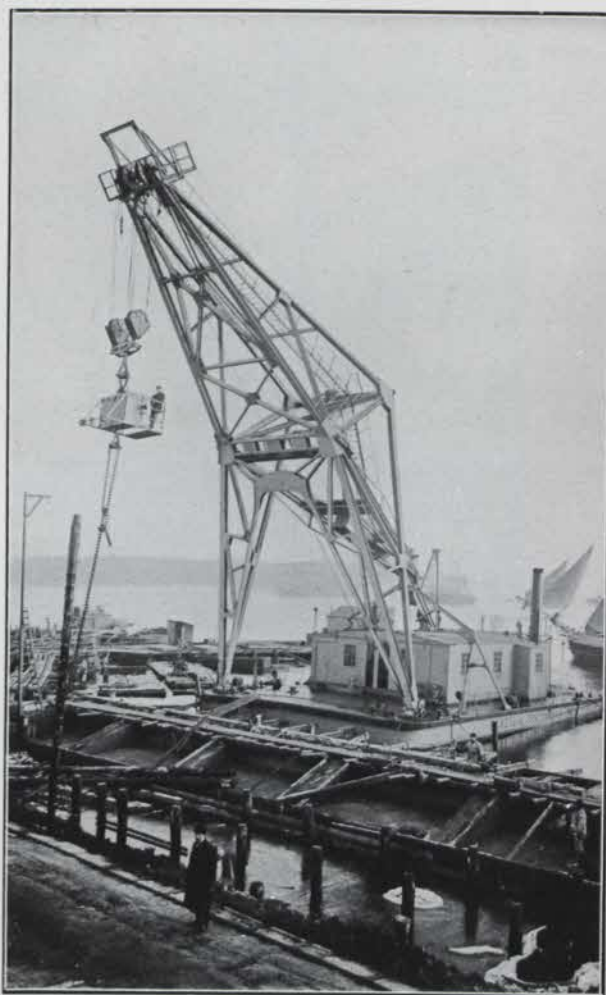
UPPDRAGNING AF STÄLLNINGSPÅLAR BAKOM DEN FÄRDIGBYGGDA DELEN AF VÄSTRA KAJEN I TEGELVIKSBASSÄNGEN MED TILLHJÄLP AF 60 TONS PONTONÄNGKRAN.
