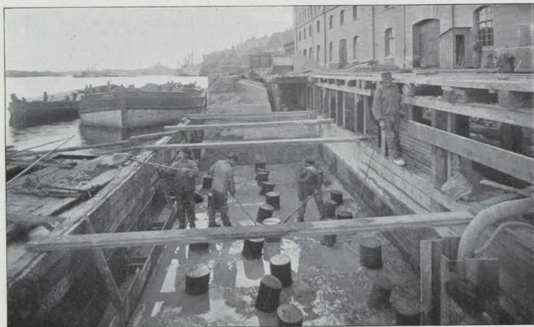
LÄNSPUMPAD KASUN OVANPÅ PÅLKISTA.
