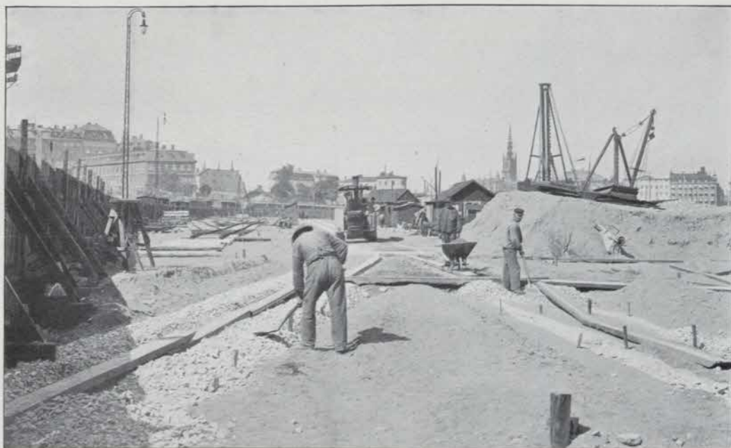
UTFÖRANDE AV MAKADAMBÄDDEN FÖR JÄRNVÄGSSPÅREN.
