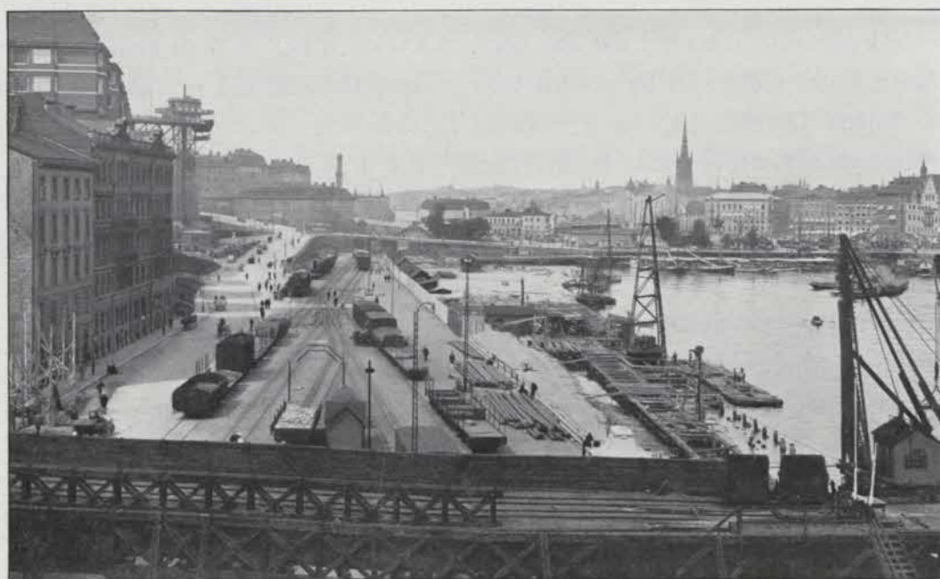
VY AV ARBETSPLATSEN OCH GAMLA HAMNBANGÅRDEN FRÅN MAGASINSBYGGNADEN, JUNI 1912.
