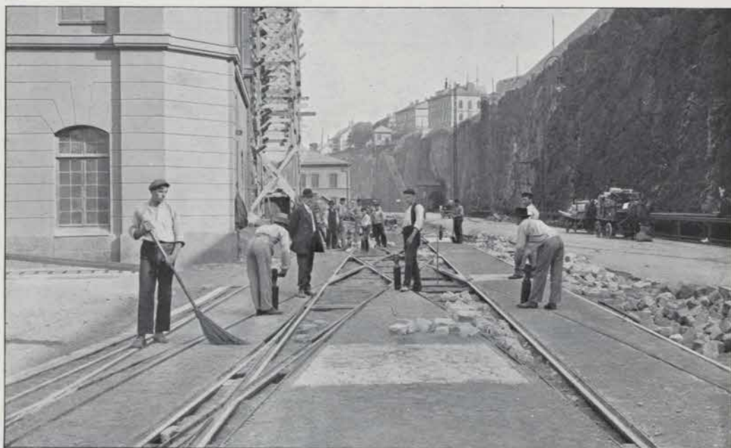
SPÅRUTLÄGGNING OCH STENSÄTTNING.
