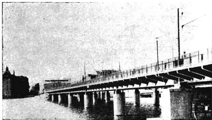
Den färdiga järnvägsbron sedd från Söder Mälmarstrand.
