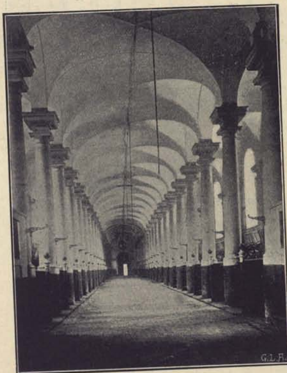
21. Gamla hofstallet, interiör.
