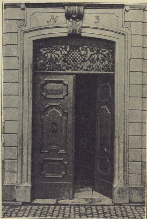
151. Portal till Grilliska huset.
