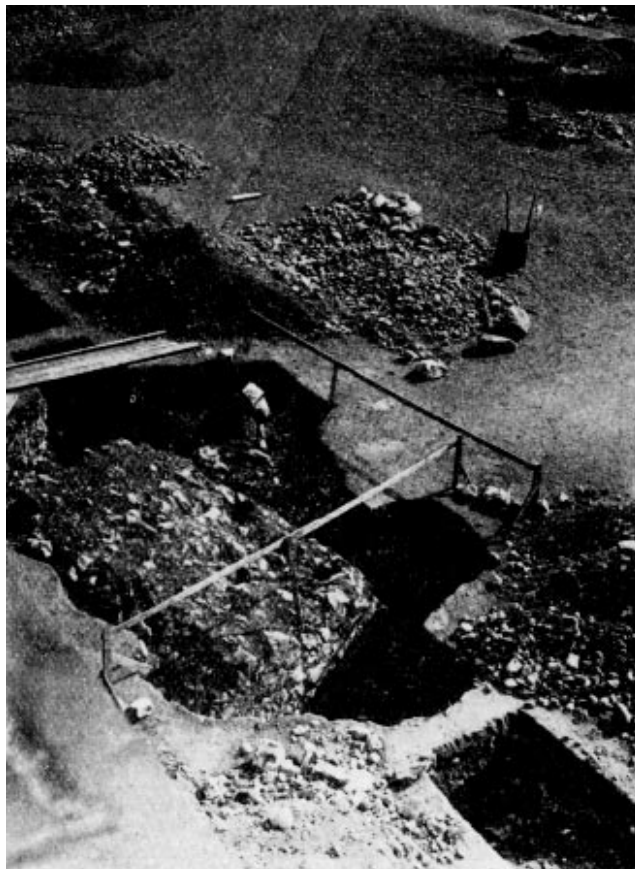
Dräneringsschakt f med muren, som har ingått i förborgens syd-mur. Foto T. O:son Nordberg 1922. SSM Repro.
