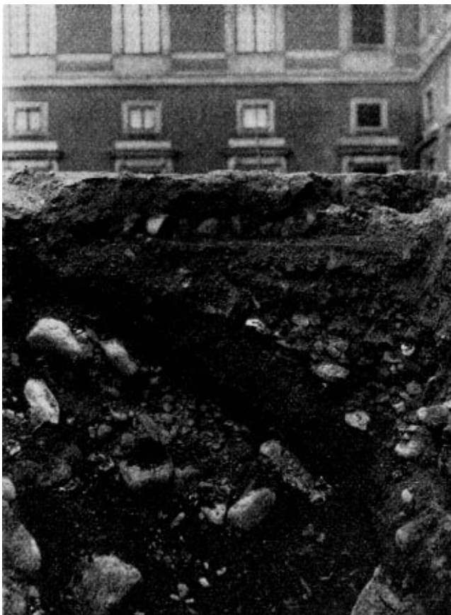
Dräneringsgravens södra sida. I schaktkanten syns den Tes-sinska gården. Det understa gruslagret med stora stenar antogs vara åsen. Foto T. O:son Nordberg 1922. SSM Repro.
