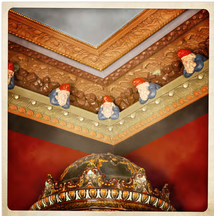
Herrummet efter renoveringen år 1998. Tomtarnas röda luvor ger julkänsla, men efter den senaste analysen av underliggande färglager står det klart att färgen från början var mer diskret. Det var de färgnyanserna Axel Notini använde när han färdigställde sitt arbets- och rökrum. Foto: Johan Stigholt. SSM.
