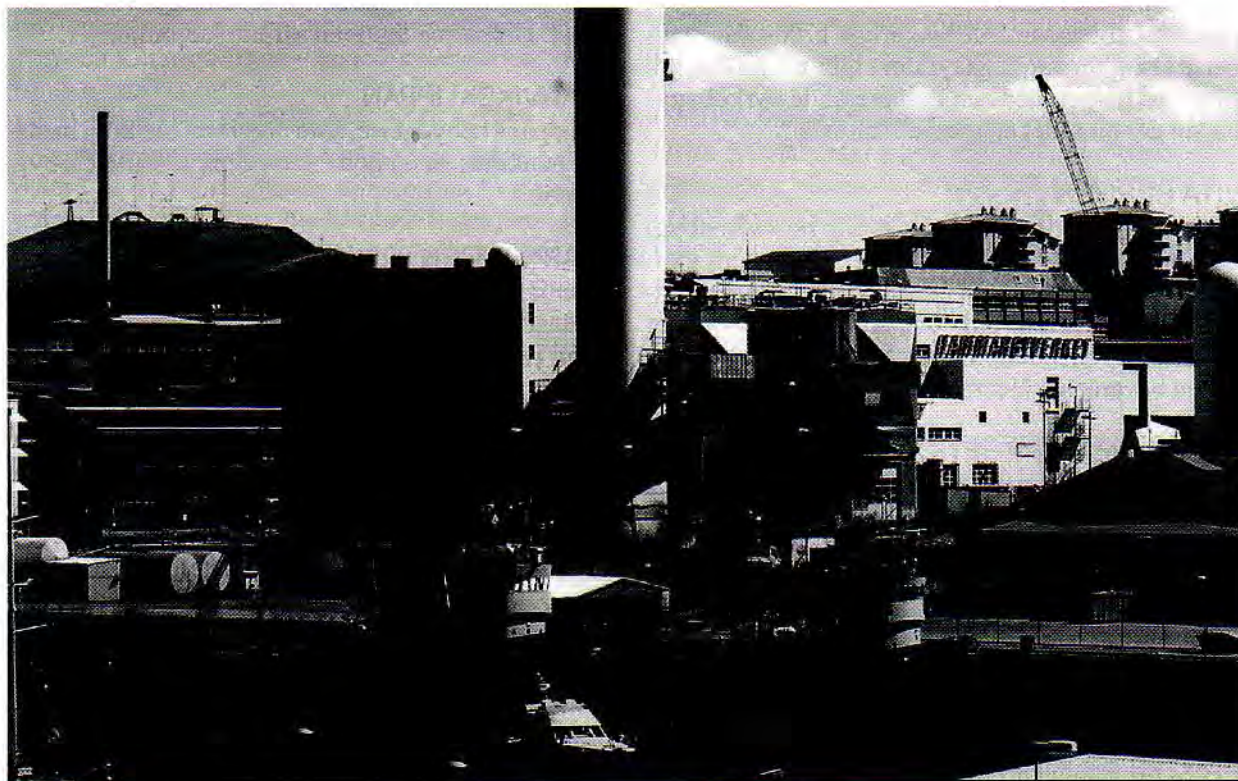
Fjärrvärmeanläggning vid Hammarbyverket
