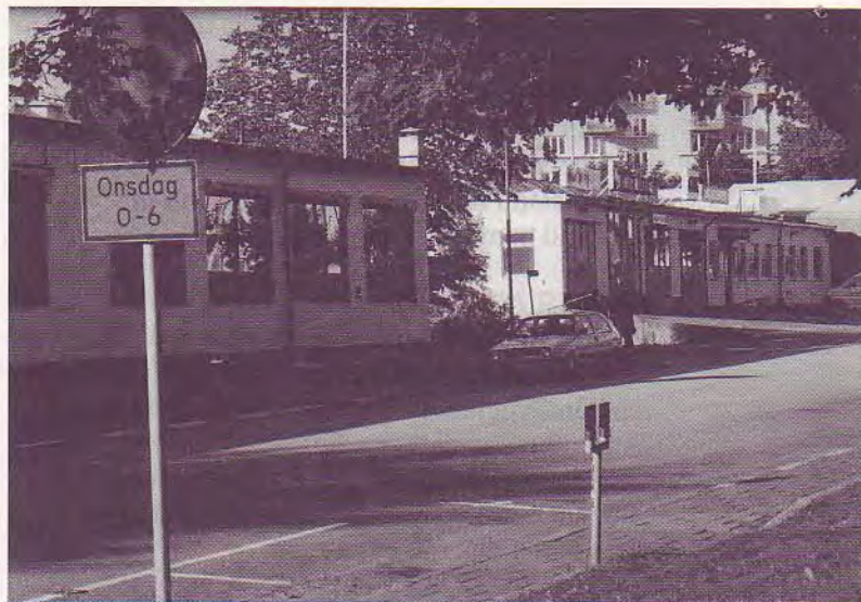
Industri- och kontorshus vid Tantogatan
