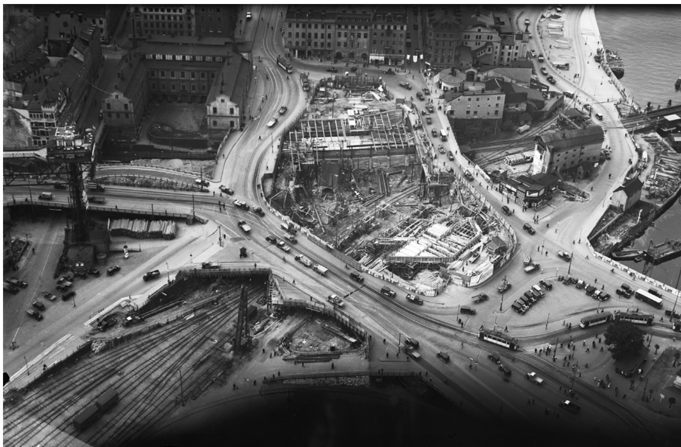
Ombyggnaden av Slussen på 1930-talet. Foto: Oscar Blad. SSM.
