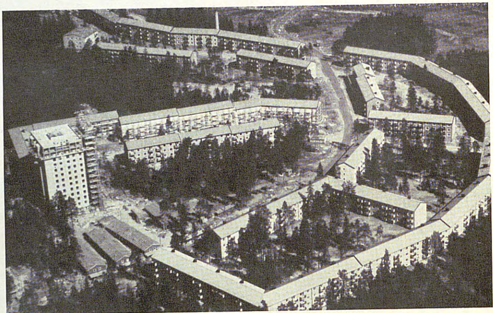
Genom att bygga samman smalbusen i långa längor har man kunnat samla den obebyggda marken till ett fåtal stora gårdar där varje kvarter har tillgång till goda lektytor.
