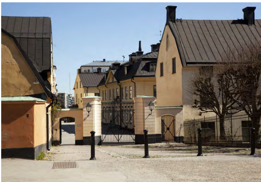
Entrén till Barnängens gård från Barnängsgatan. Genom porten kommer man till anläggningens centrala del och den stora gårdsplanen. Rakt fram syns huvudbyggnaden, uppförd mellan åren 1767 och 1769. Till höger syns den i dag äldsta bevarade byggnaden, verkhuset från 1741. Till vänster skymtar portvaktbostaden från år 1782. Foto: Ingrid Johansson 2010. SSM.
