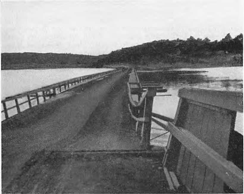
Förbindelseleden mellan Kungsholmen och Bromma ett 60-tal år: pontonbrons föregångare flottbron.
