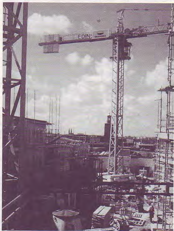
Parkeringshuset Wahrenberg har byggts till med bostäder
