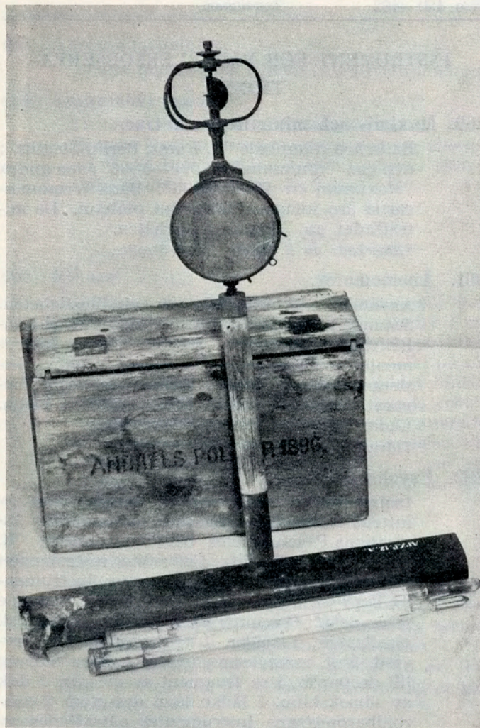
EXPEDITIONENS ANEMOMETER OCH MAXIMI- OCH MINIMITERMOMETRAR.
