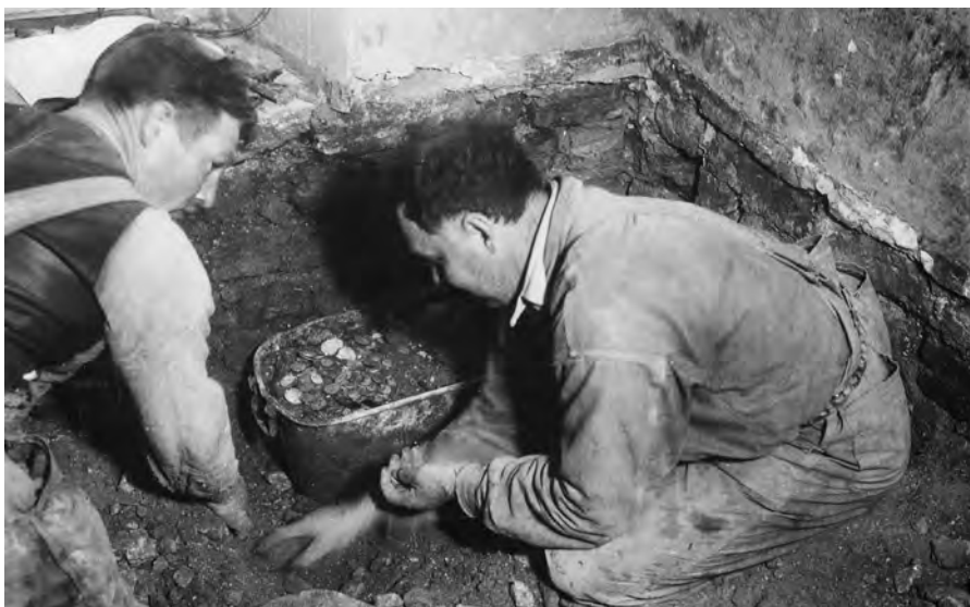
Arbetarna Westerberg och Karlsson demonstrerar hur det gick till när skatten hittades under det gamla golvet. Foto: G. Löwendahl. SSM.
